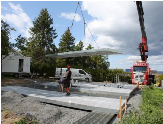
Figur 2. 8: Andra lagret av Foamglasskivor (Evia, 2022) Figur 2. 9: Koljern-elementen lyfts på med kran (Evia, 2022)
