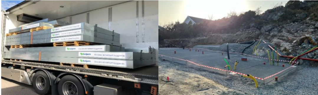
Figur 2. 2: Leverans av Koljern-element (Evia, 2022) Figur 2. 3: Förberedelse av mark (Evia, 2022)
