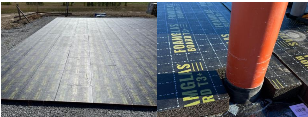
Figur 2. 4: Första lagret av Foamglasskivor (Evia, 2022) Figur 2. 5: Utskärning för installationer (Evia, 2022)
