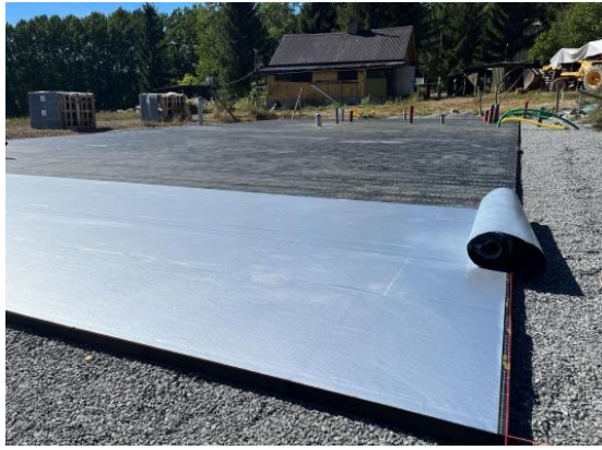
Figur 2. 6: Placering av radonduk (Evia, 2022)
