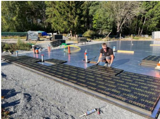
Figur 2. 8: Andra lagret av Foamglasskivor (Evia, 2022) Figur 2. 9: Koljern-elementen lyfts på med kran (Evia, 2022)
