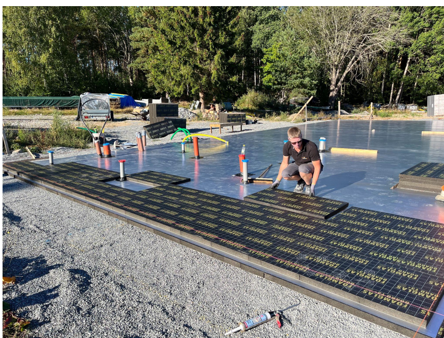
Fig 4.1: montering av andra lagret av FOAMGLAS® FLOORBOARD isolering "B" mm från byggnadens färdiga utsida.
